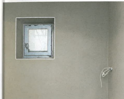
Der sanierte Kellerraum ist jetzt von innen dauerhaft vor Feuchte geschützt.
