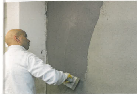
Auftrag der Kombiflexabdichtung auf Dichtputz respektive Wassersperputz.
